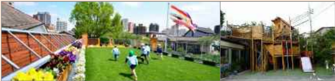
屋上の芝生園庭，千住寿幼稚園（第 14 回 審査委員会特別賞：屋上緑化部門）
