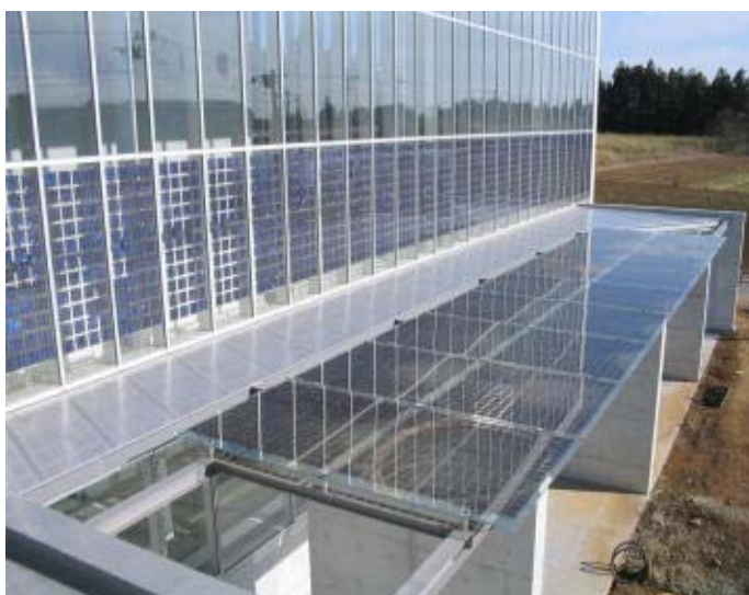
プールサッシ部・駐輪場屋根
