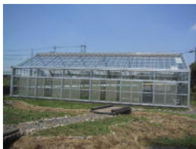
土壌浄化施設
