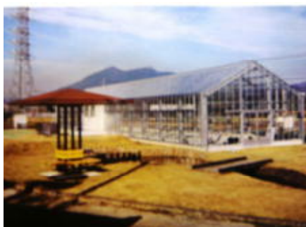
佐地区生活排水路浄化施設
