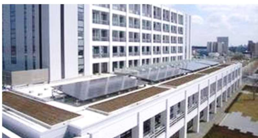
公共施設の太陽光発電設備
