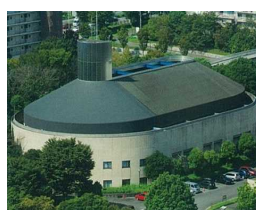
熱供給プラント外観
