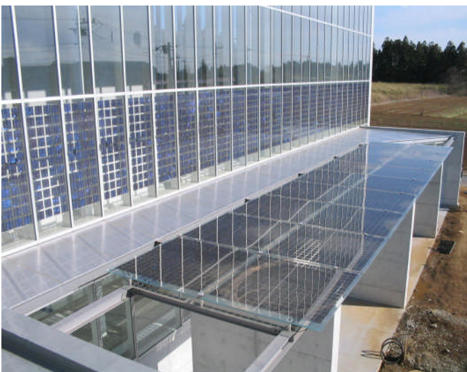
プールサッシ部・駐輪場屋根
