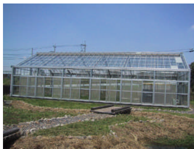
土壌浄化施設
