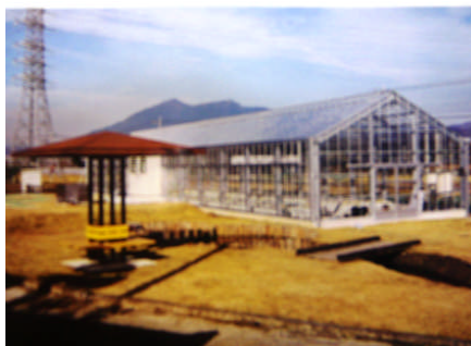
佐地区生活排水路浄化施設
