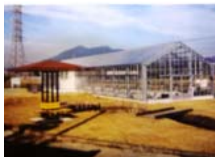
佐地区生活排水路浄化施設
