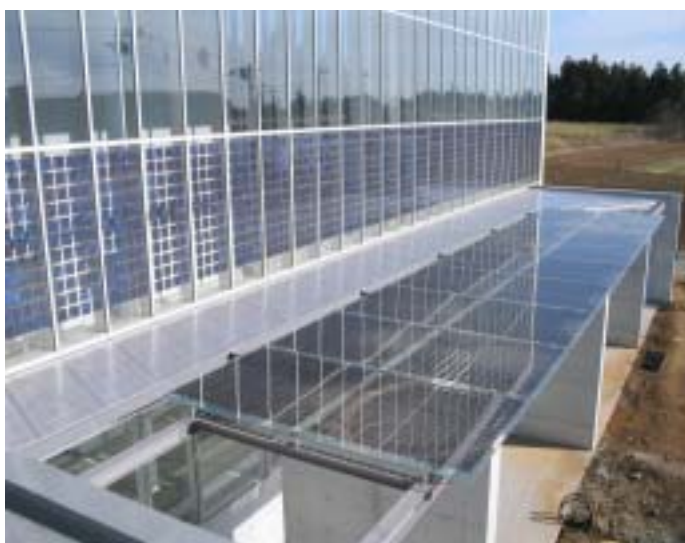
プールサッシ部・駐輪場屋根
