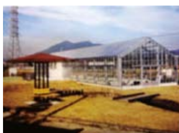
佐地区生活排水路浄化施設
