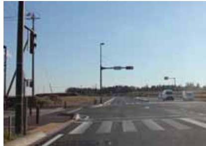
自歩道の整備事例(新都市中央通り線)
