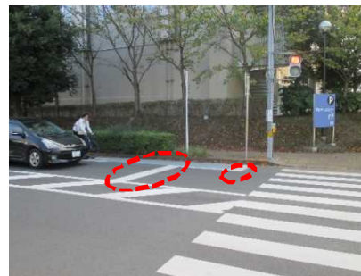
停止線を車より前方に設置
