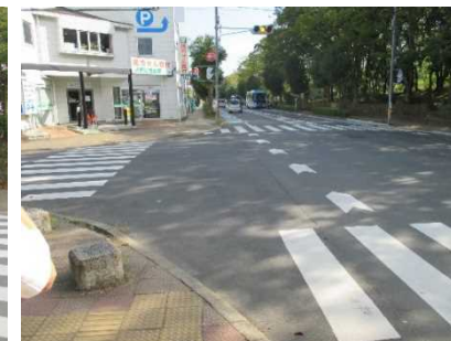
交差点への矢羽根設置
