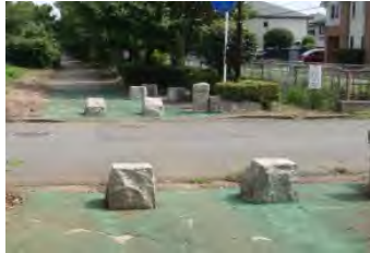
図 6-29 反射材のない車止め
