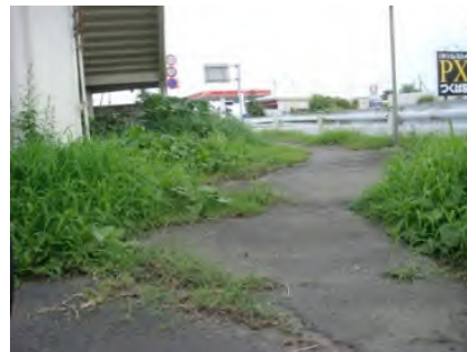
図 6-18 舗装劣化
