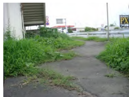
図 6-12 舗装劣化
