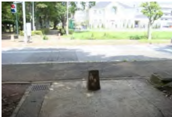
図 6-300 認識しにくい車止め
