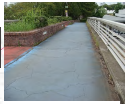
舗装の劣化（路面標示の色あせ、ひび割れ）（区間⑥）
