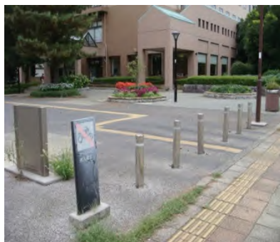
間隔が狭く、複数設置されている車止め（区間①）
