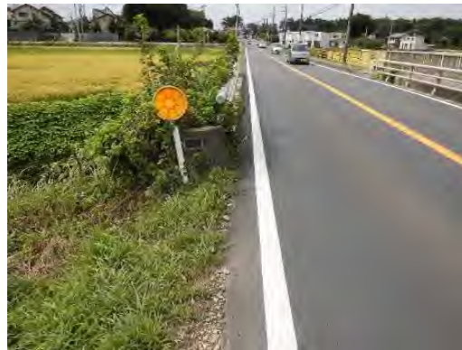
路肩の狭さ(豊里地区)
