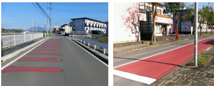
連続段差舗装
