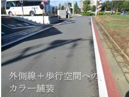
外側線・カラー舗装、連続段差舗装
