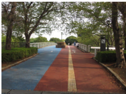
自転車通行帯を設けたペDESTリアンデッキ
