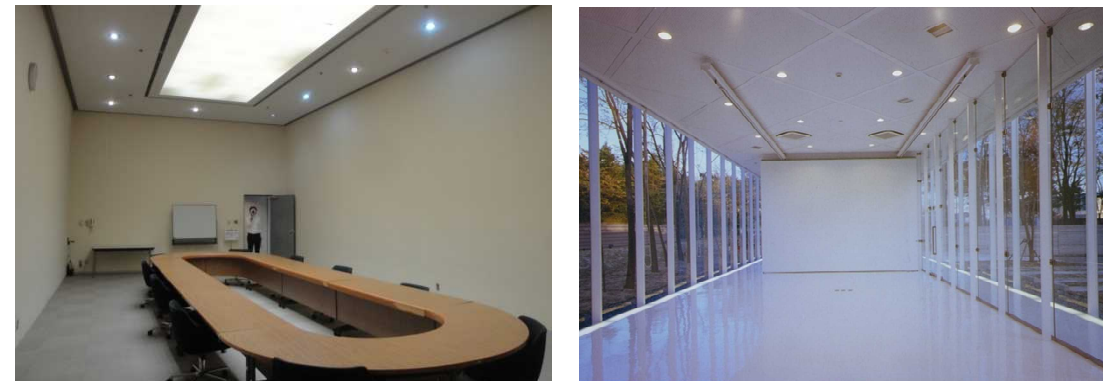
左：会議室Bの現状 右：稼働間仕切りの参考例
