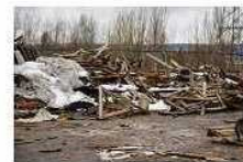
災害時瓦礫置き場
