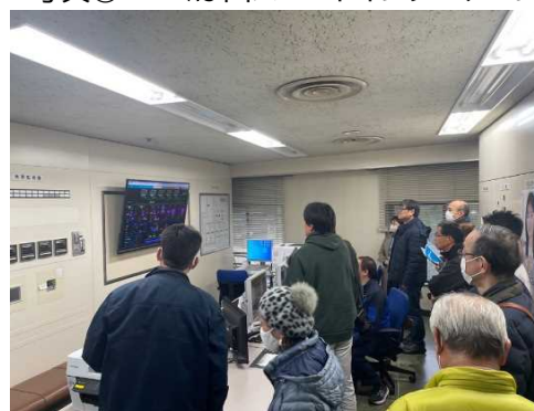
写真④ 地域冷暖房施設2
