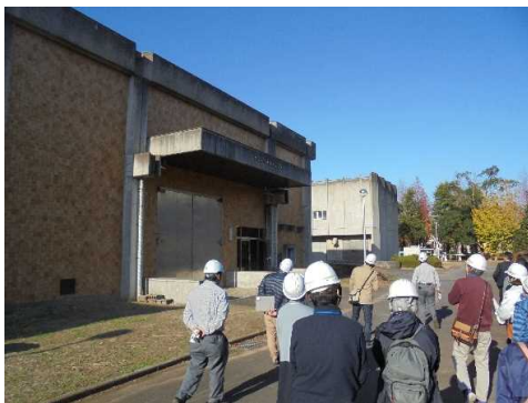
（下横場ポンプ場）
