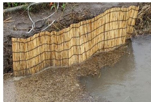
様々な資材を活用した防止柵の設置
