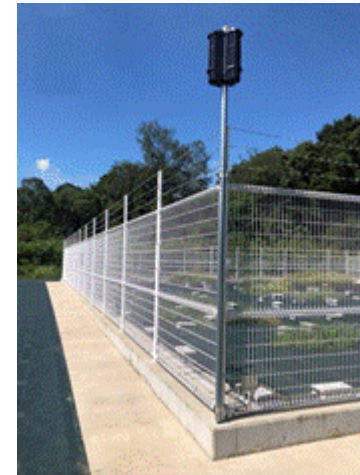
横からみた隔離ほ場のフェンスと側溝の構造
