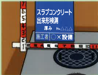
⑯ 上部スラブコンクリート 厚み確認 H=△△△
