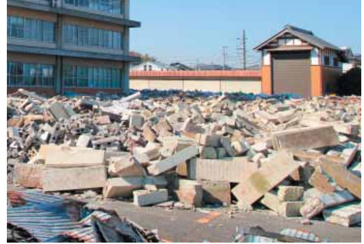
集められたがれき(旧谷田庁舎)
