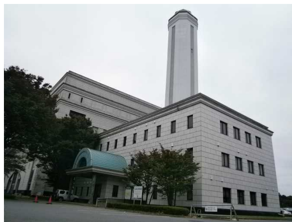
供給処理施設 (クリーンセンター)
