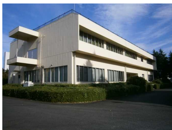
下水道施設 (下横場中継ポンプ場)
