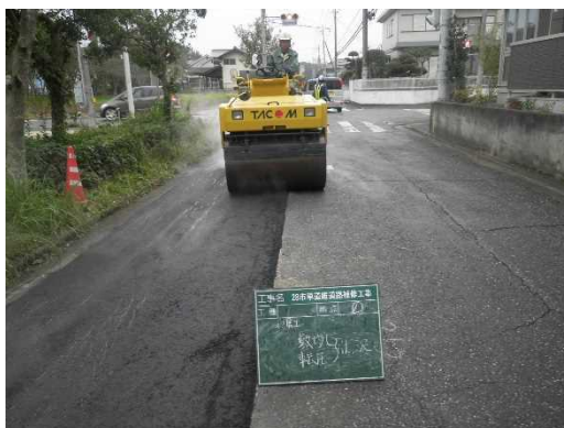
道路 (舗装の打ち替え工事)
