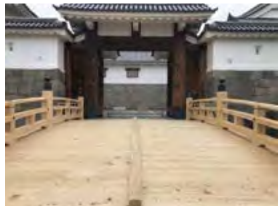
酸化亜鉛樹脂加圧含浸処理を用いた整備事例 （駿府城車御内橋・静岡県静岡市）
