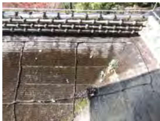
敷き込み銅板（偕楽園好文亭・水戸市）
