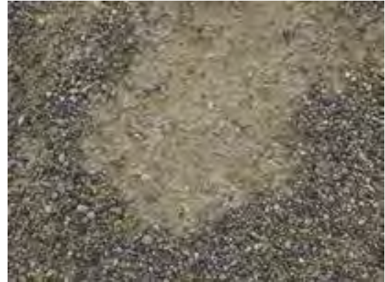
透水カラー舗装（分離した化粧砂利と表層）
